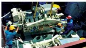
Pemasangan jentera utama kapal
